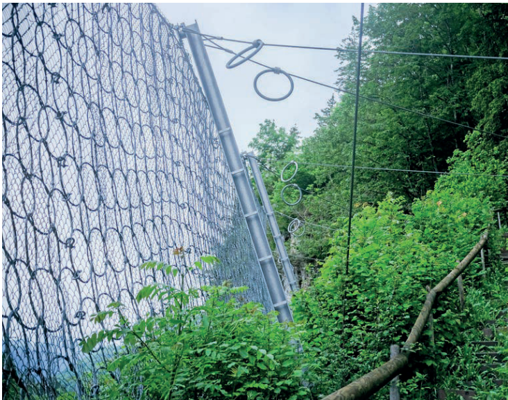
Das Metallnetz kann kleineres und mittleres Gestein fernhalten, nicht jedoch eine ganze Felswand.
